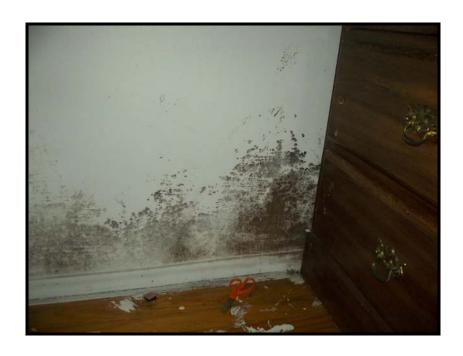
PHOTOGRAPH NO. 19: TYPICAL VIEW OF MOISTURE INTRUSION OBSERVED IN TENANT UNIT 3681
